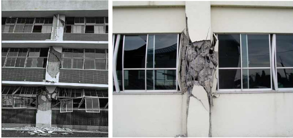
[그림 1.6] 단주효과에 의한 학교건물의 지진피해 상황
